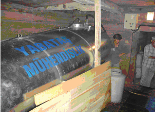
Kastamonu ili Şenpazar İlçesi Aşıklı Köyü'nde kurulan beş süt ineğinin atıkları ile işletilen tesis
